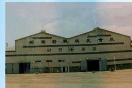
→ 포항 주물공장 준공
