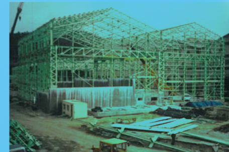
→ 포항 주물 2공장 공사현장
