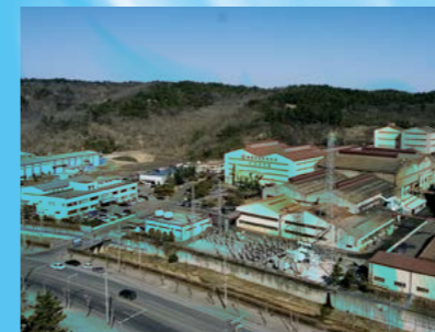
→ 포항 주물공장, 가공공장 증설
