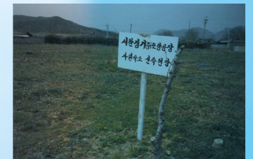
→ 포항공장 사원숙소 신축현장
